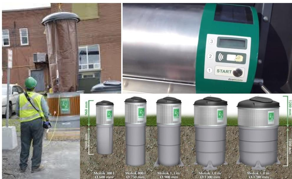
Slika 4.6: Postupak pražnjenja spremnika, detalj zatvarača s kartičnom kontrolom pristupa i prikaz veličina spremnika (MOLOK Ltd., STP d.o.o)
